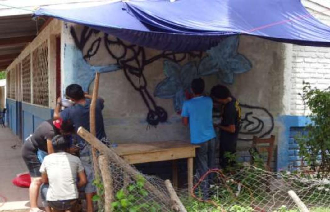
Bevor dann die Mischung an die Wand kommt muss erst noch Plasterbond drangepinselt werden. Das ist der hellblaue spezielle Fliesenkleber, Alex kommt mit dem "brei" in der Schüssel und dann mit einem umgedrehten Esslöffel Stück für Stück, mit einem gewissen "Dreh" an die Wand
