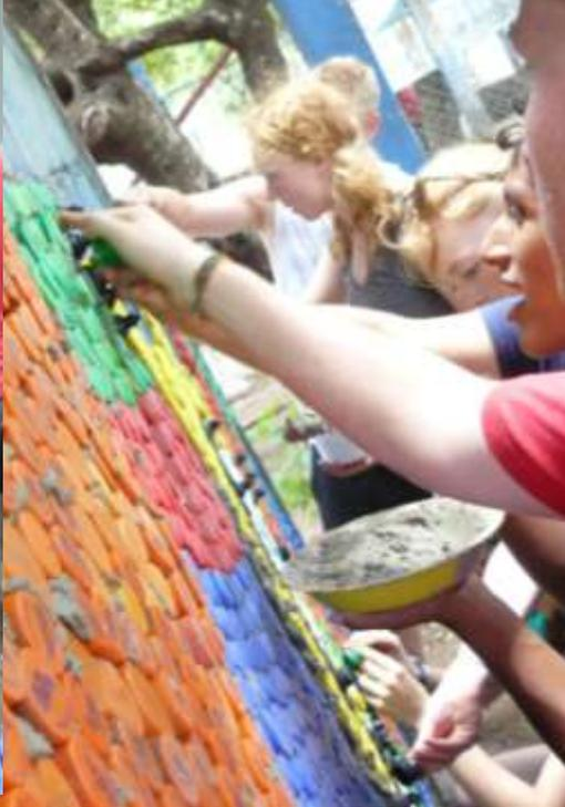
Die Zementmischung haben wir mit einem Löffel aus einer Schüssel, an die Wand geschmiert. Löffelchen für Löffelchen. Während ein anderer in diese Masse dann die Plastik-Deckel reindrückt. Die Linien und Farben wurden einzeln gearbeitet und man hofft, dass nachher alle gut zusammenpassen. Wenn keine grossen reinpassten, benutzten wir die Kleinen.
