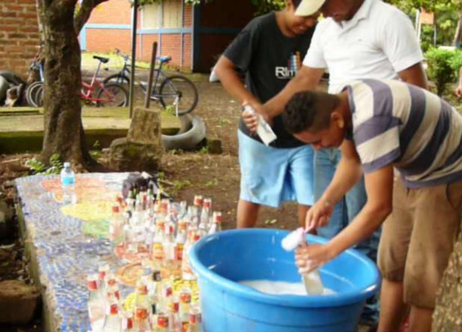
Zuerst wird alles vorbereitet, Flaschen gewaschen, Zementmischung in einer grossen blauen Wanne zubereitet, ausgegraben und Steine verschiedenen Grössen gesammelt. Dann endlich werden Reihe für Reihe die Glasflaschen mit Zementschichten dazwischen hochgezogen. Einige der Jungs arbeiten interessiert mit.
