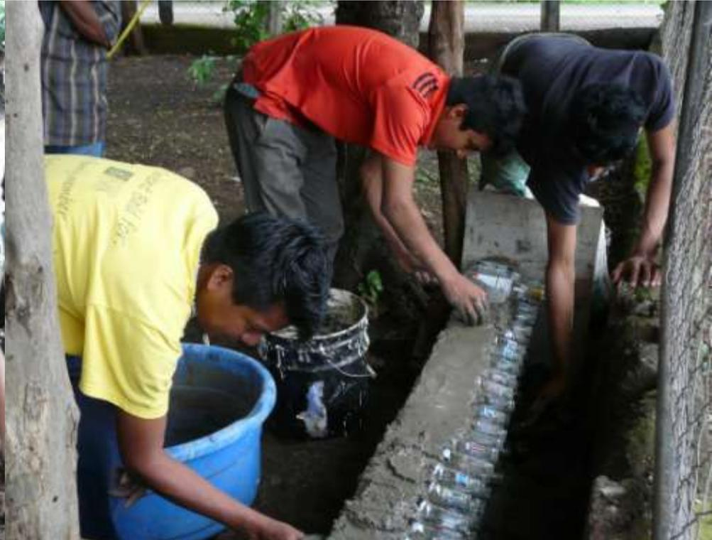
Alex zeigt ihnen mit Geduld die verschiedenen Kniffe und Details. Der hintere Teil wird vorsichtig mit Steinen angefüllt und die Flaschenböden werden liebevoll geputzt. Danach kommt dann oben ein Maschendraht drauf und eine abschliessende Zementschicht und fertig ist die schöne Bank.
