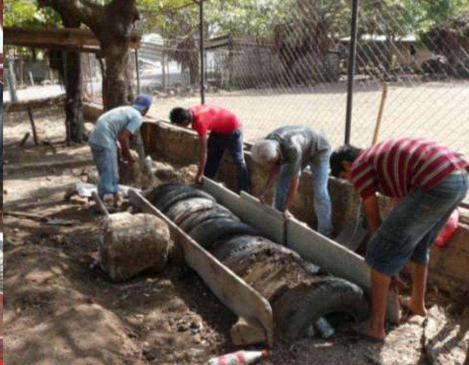
An den Seiten wird auch alles noch mit Eco-Flaschen ausgelegt und ruletzt eine Sicht Sotter. Dann verschwindet alles unter einer doch recht soliden Zementschicht in die Alex rillen reinritzt, damit wir danach noch ein Bild aus Plastikdeckel druafmachen können.
