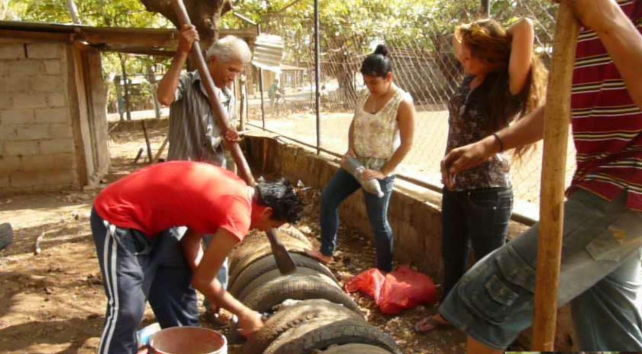
Zuletzt kommt noch eine schicht steine rein, denn die verbinden sich besser mit dem Zement. Und aussendrum kommt eine Bretter-Verschalung um dem ganzen eine Bank-Form zu geben.
